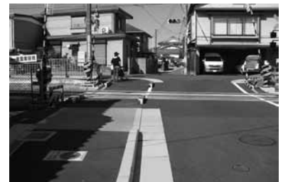
道路改良事業 (南・中学校線)
