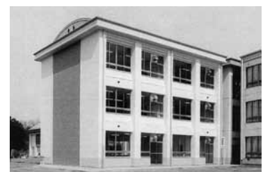
精華西中学校の校舎増築部分
