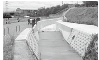
煤谷川河川改修事業 事業完了
