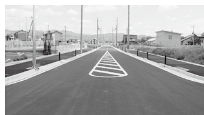
狛田駅東線工事完成
