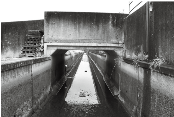
町内各所にかかる橋りょう
