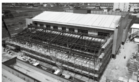
工事が進む 新消防庁舎
