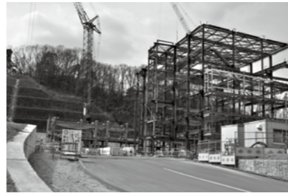
工事が進む新クリーンセンター
