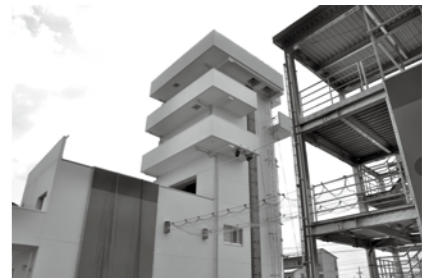
消防庁舎訓練棟
