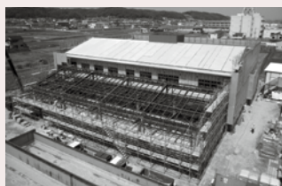
工事が進む消防庁舎
