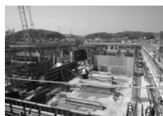
工事が進む精華中学校校舎
