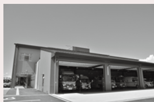
完成した新消防庁舎
