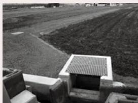
菱田八講田地区排水路整備工事
